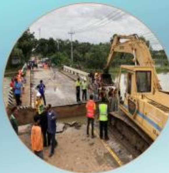
ซ่อมแซม สิ่งสาธารณประโยชน์
